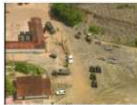
Fig. 18 - Instalações do Destacamento - Lote 6.
