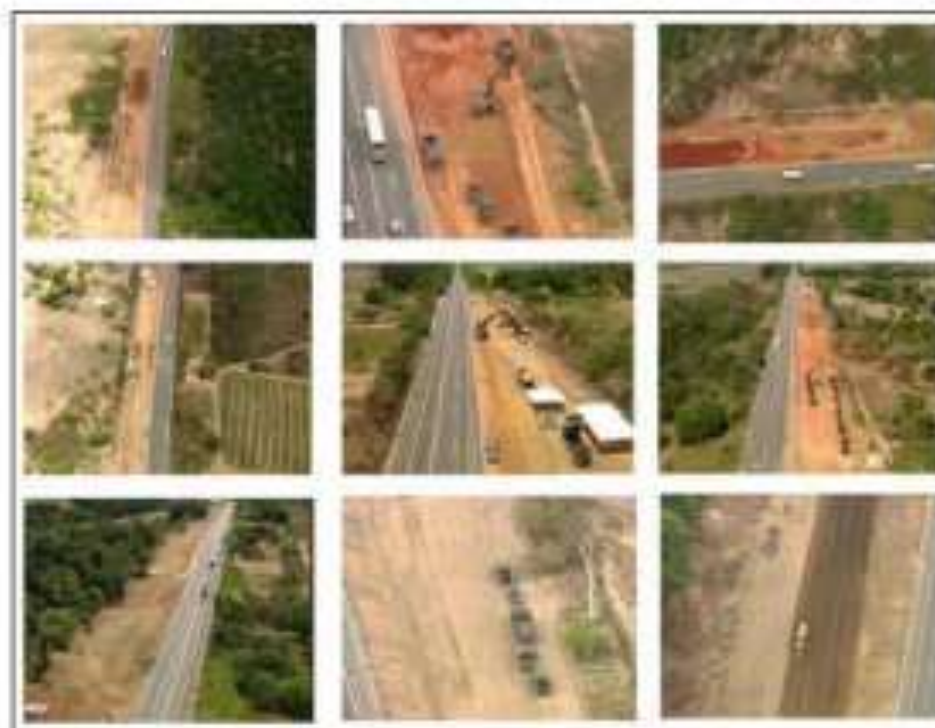
Fig. 19 - Exemplos de imagens sobre áreas de obras da BR-101 NE.
