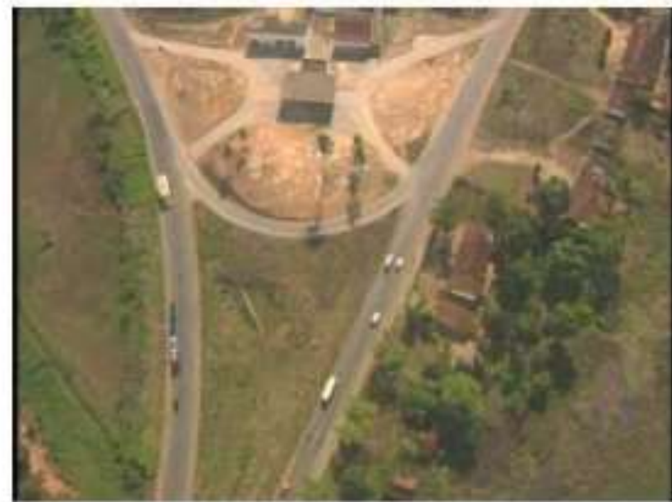
Fig. 14 - Exemplo vôo vertical - Final do trecho do sobrevo após Palmares e após final do Lote 8, ponto extremo sul ainda em Pernambuco.
